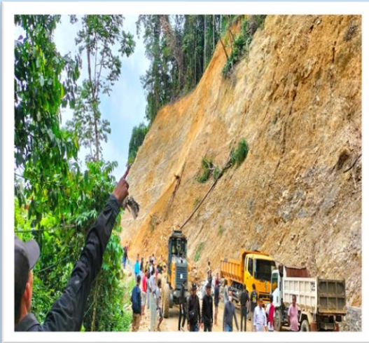
Penanganan Longsor di Desa Kasintuwu Kec. Mangkutana
