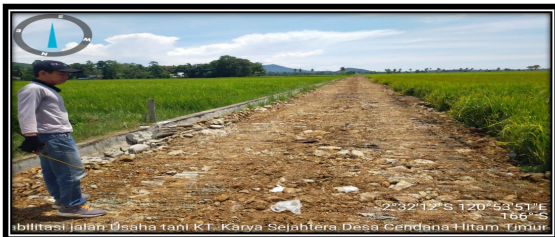
Kegiatan pembangunan/Pembentukan Jalan Usaha Tani (JUT)
