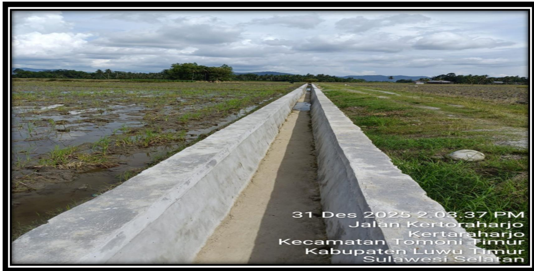
Kegiatan pembangunan Jaringan Irigasi Desa (JIDES)
