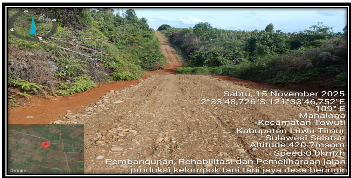
Kegiatan Pembangunan/Pembentukan jalan Produksi (Japro)
